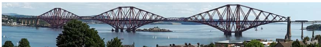
Рис. 1. Мост через залив Ферт-оф-Форт, Шотландия 1
