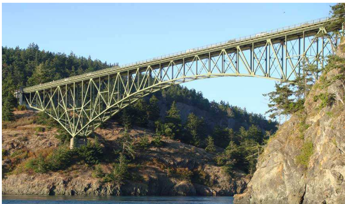
Рис. 3. Автомобильный мост в штате Вашингтон, Сиэтл, США
