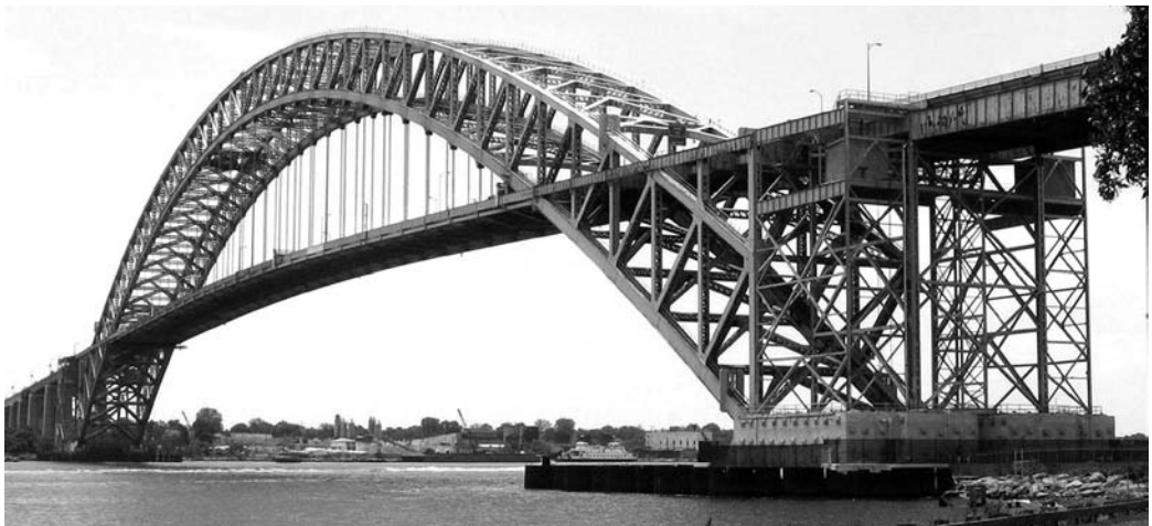
Рис. 1. Бейонский мост, Нью-Джерси, США [1]
